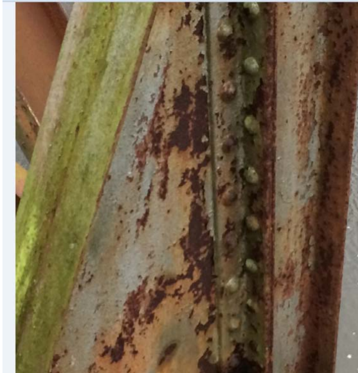
Knæ samler/afstiver lodposte med tværgående bjælker.
