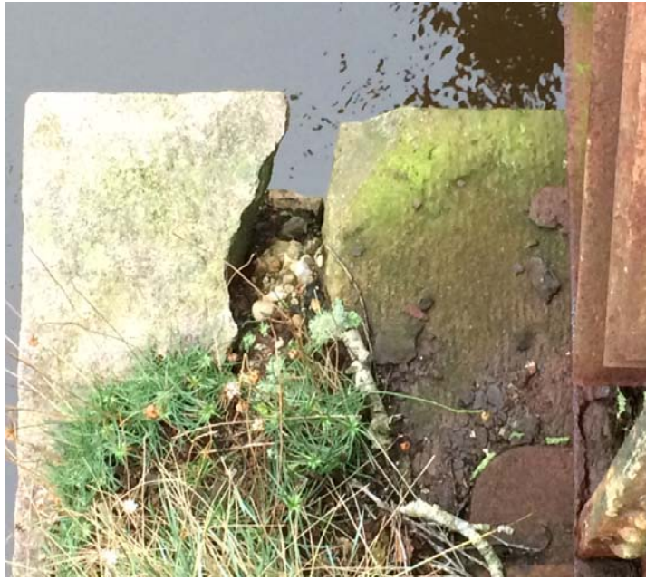
Betondelen skal have en ny overflade.
