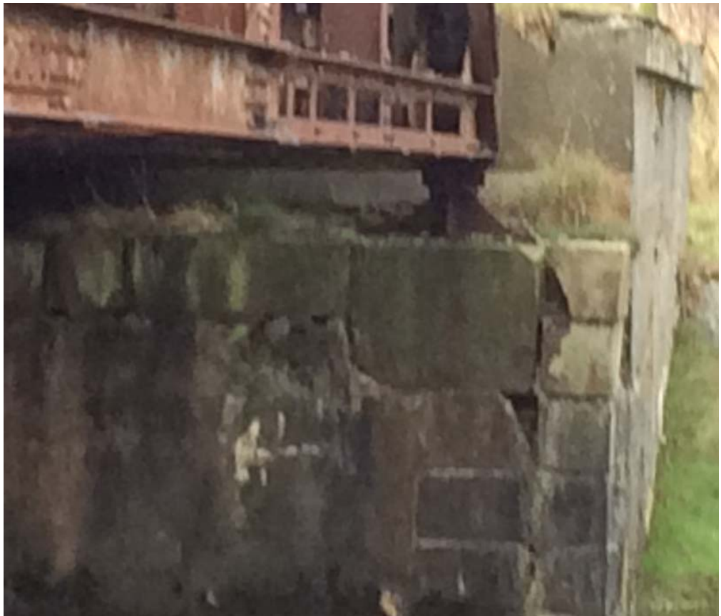
Boreprøve er udført på vestenden på sydside af betonfundament.
